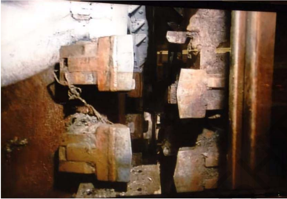
Рисунок 12 – Стыковка 2 щитов
