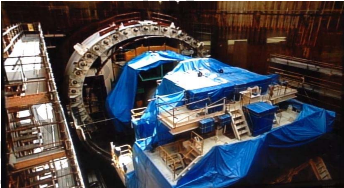
Рисунок 9 – Сборка щита
