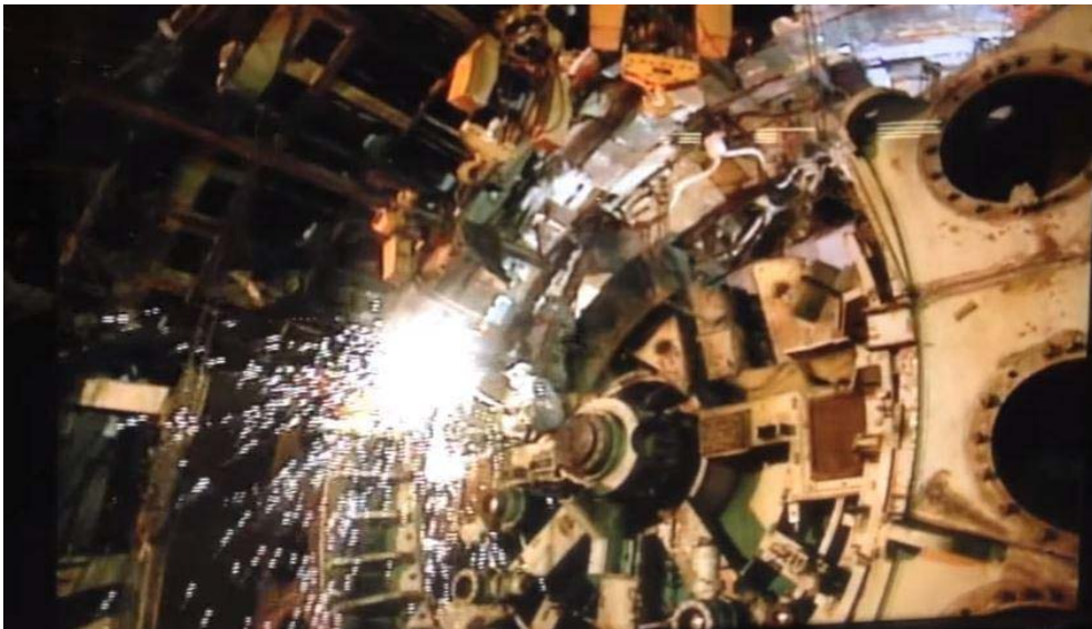
Рисунок 13 – Демонтаж щитового комплекса
