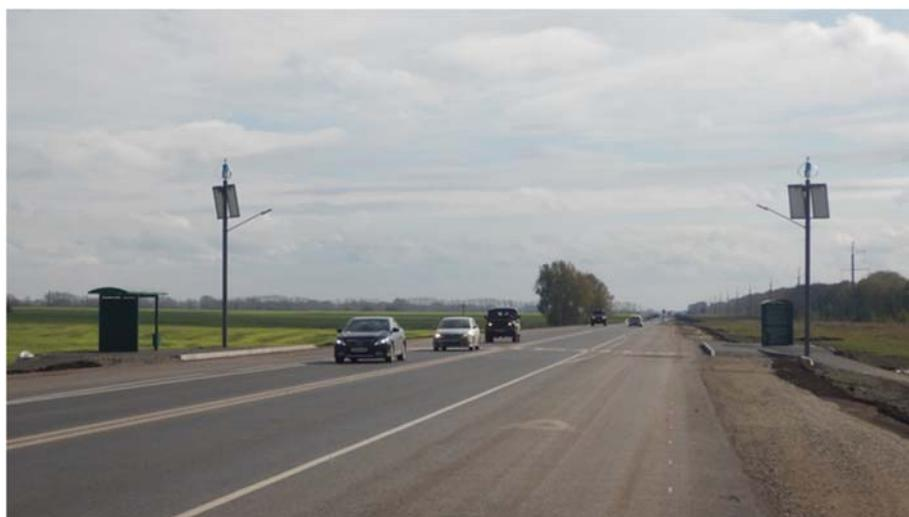
Рисунок 1 – Ветро-солнечные системы для освещения пешеходного перехода
