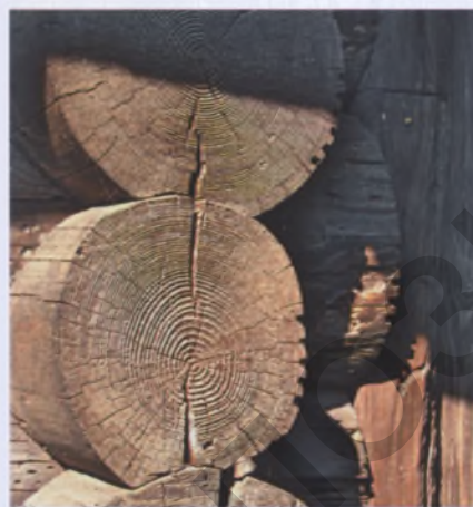
Рисунок 6 — Монтажные знаки на срубе жилого дома в Семенево Копыльского района. Начало XX в.
