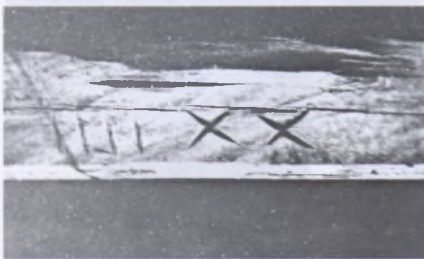
Рисунок 8 — Монтажный знак на стропилах жилого корпуса монастыря бригиток в Гродно. Середина XVII в.
