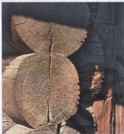
Рисунок 6 — Монтажные знаки на срубе жилого дома в Семежево Копыльского района. Начало XX в.
