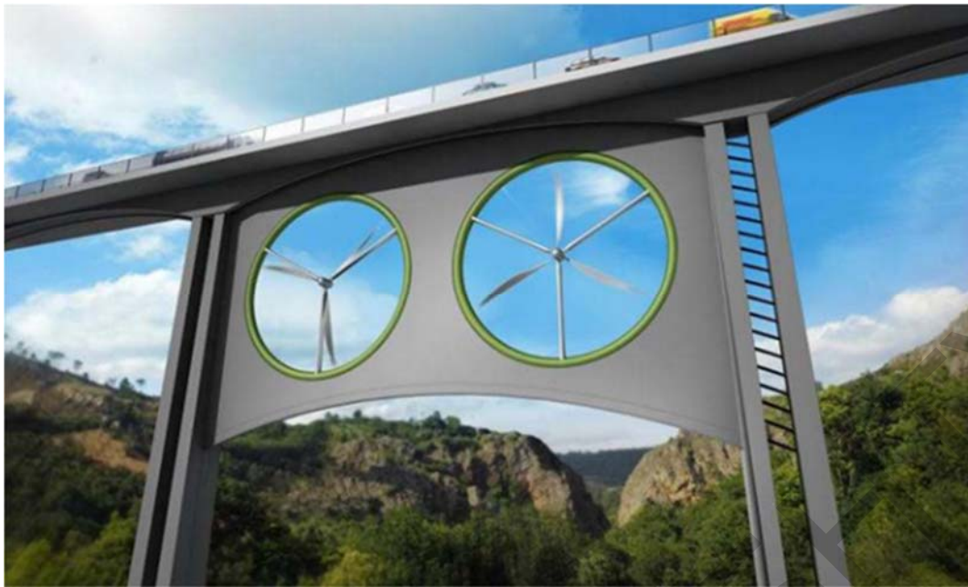
Рисунок 3 – Виадук с ветровыми турбинами между опорами
