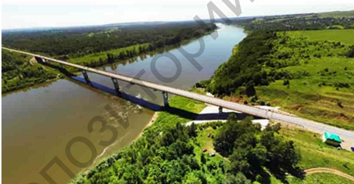
Рисунок 3 – Общий вид моста
