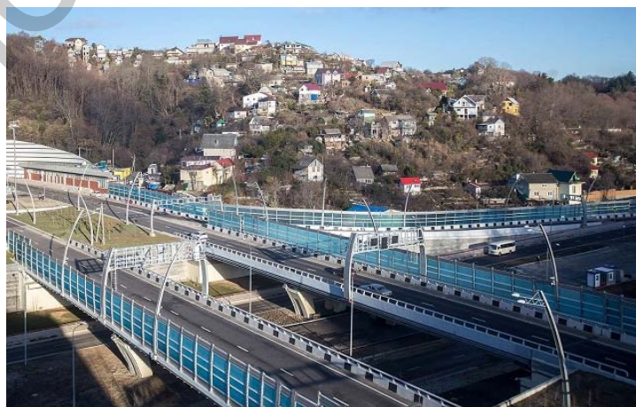
Рисунок 4 – Путепровод с шумозащитным экраном
