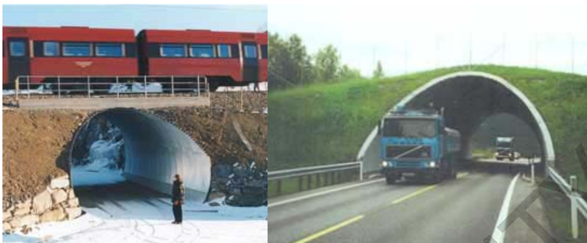
Рисунок 1 – Использование гофрированных конструкций в транспортном строительстве
