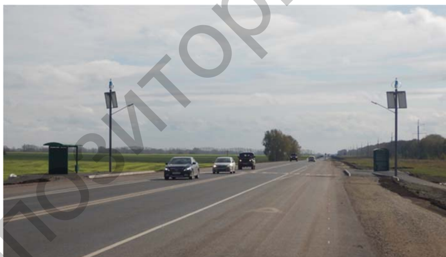
Рисунок 1 – Ветро-солнечные системы для освещения пешеходного перехода
