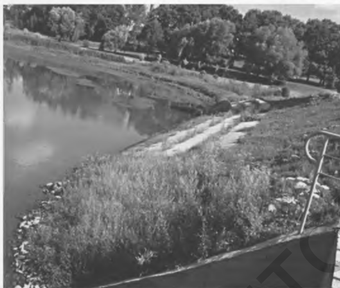
Рисунок 1 — Земляная плотина водохранилища «Лошица-2»
