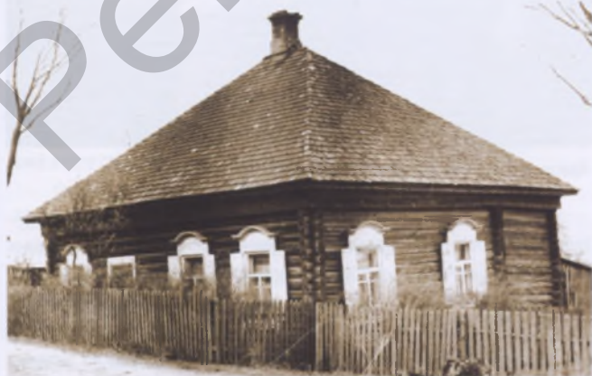
11 — Жилой дом в Городке Глусского района
