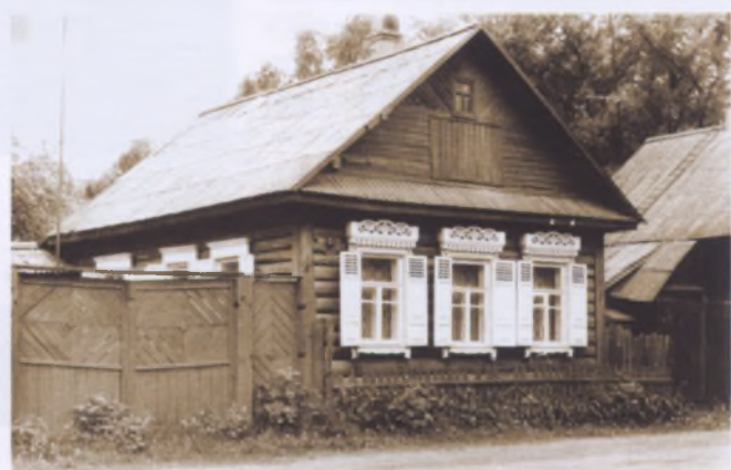
13 — Жилой дом в Рогачеве
