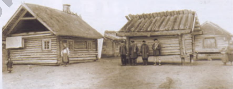
3 — Застройка деревни Большие Чучевичи Лунинецкого района (Фото начала XX в.)
