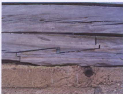
Рисунок 2 — Продольное горизонтальное соединение в усложненный косой накладной замок. Нижний венец жилого дома в Зарачанах Пуховичского района
