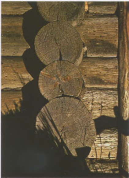
Рисунок 20 — Стена жилого дома в Гороховцах Солигорского района
