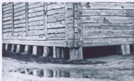
Рисунок 11 — Фундамент амбара в Рудном Копыльского района
