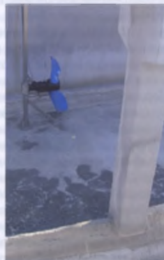
Рис. 4. Перемешивание иловой смеси погружной лопастной мешалкой
