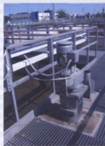
Рис. 3. Перемешивание иловой смеси в денитрификаторе лопастной мешалкой с вертикальным трансмиссионным валом
