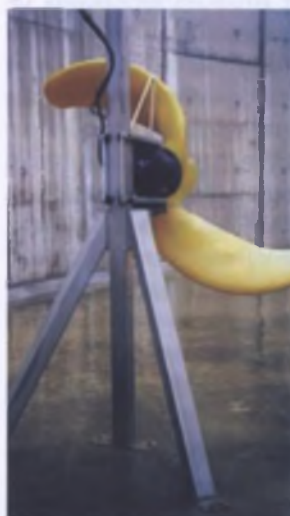
Рис. 4. Перемешивание иловой смеси погружной лопастной мешалкой
