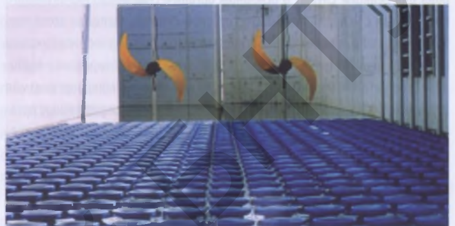
Рис. 6. Вид циркуляционного окислительного канала для параллельной денитрификации
