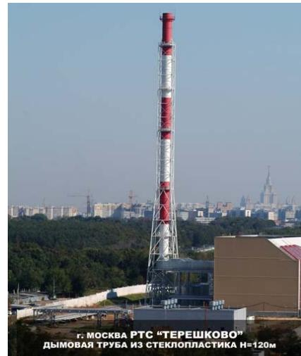
Рис. 3. Стеклопластиковые дымовые трубы
