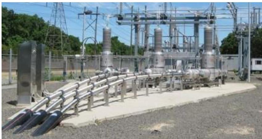
Рисунок 4. ВТСП-кабель 138 кВ (2400 А) длиной 660 м.
