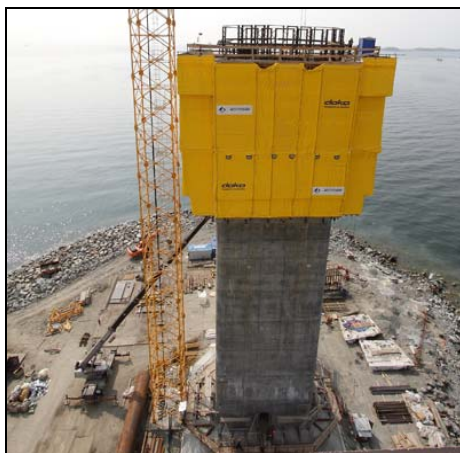
Рисунок 2 – Самоподъемная опалубка
