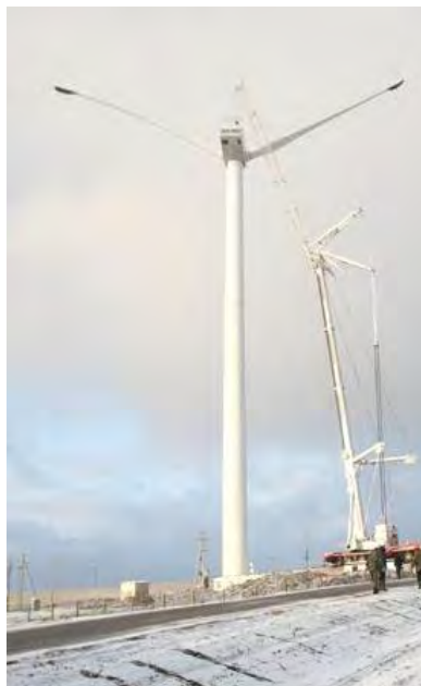
Рисунок 2. Монтаж ВЭУ-1,5 МВт коммерческого диапазона, Новогрудский район
