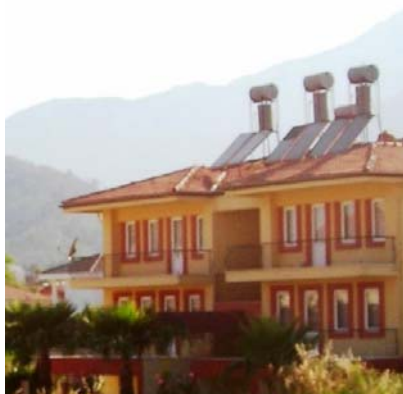
Рис. 1.1. Конструкция небольшой гелиосистемы с естественной циркуляцией теплоносителя в контуре гелиоколлектора – одноконтурная схема с верхним расположением бойлера
