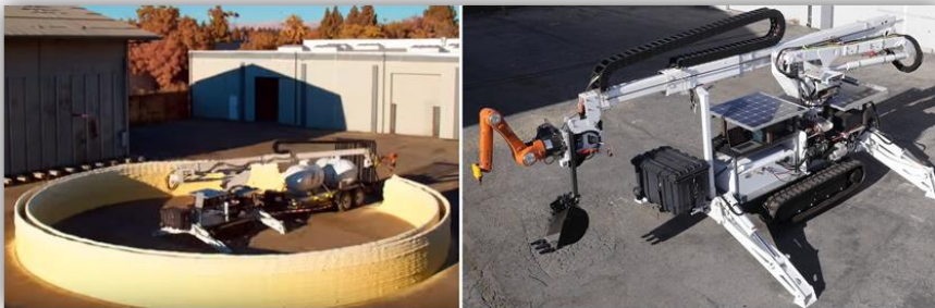
Рис. 4. Реализация способа формования второго типа при помощи Digital Construction Platform, MIT, США.
