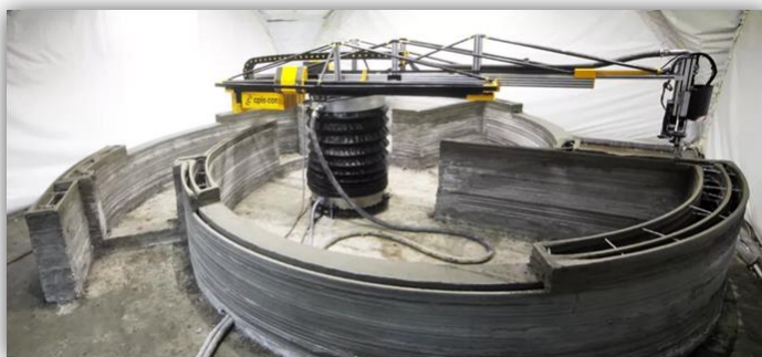
Рис. 3. Реализация способа формования первого типа при помощи Aris Cor
