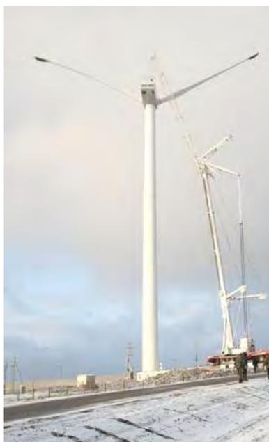
Рисунок 2. Монтаж ВЭУ-1,5 МВт коммерческого диапазона, Новогрудский район
