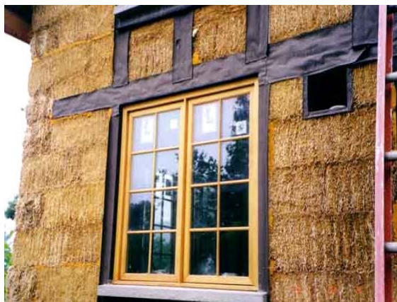
Рисунок 4 – соломенный экодом. Отделка фасада
