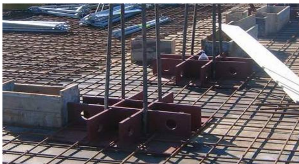
Рисунок 2. Способы поперечного армирования безригельных плит: а) – постановка арматурных каркасов; б) – постановка закладных деталей; в) - применение скрытых капителей.
