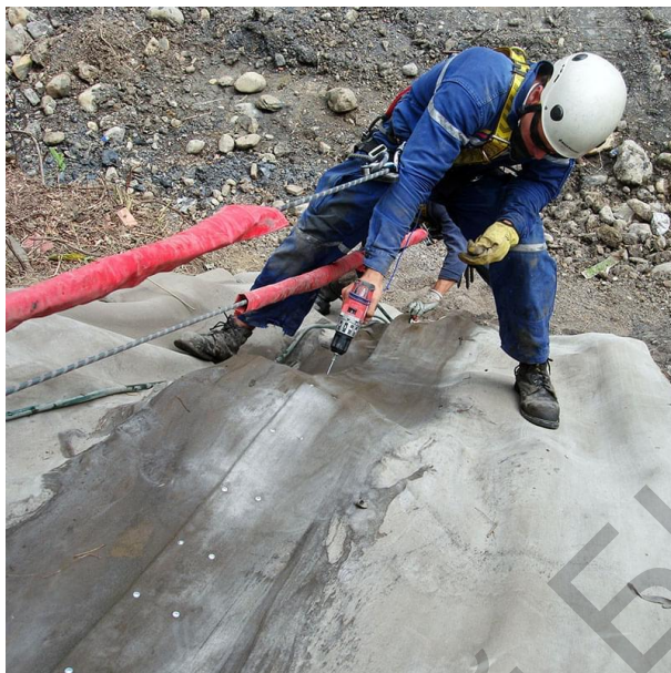
Рисунок 3 – Фиксация полотен между собой
