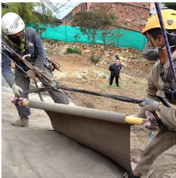
Рисунок 2 – Укладка бетонного полотна
