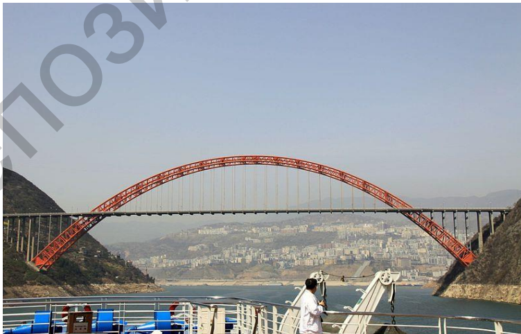
Рисунок 2 – трубобетонный арочный мост в Китае
