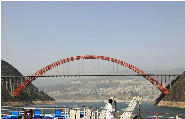
Рисунок 2 – трубобетонный арочный мост в Китае
