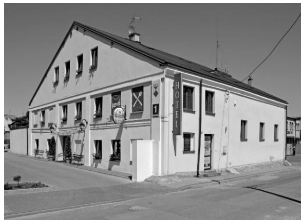
Ryc. 15. Kolno, Dom Talmudyczny, stan obecny, 2015 r. – fot. autor
