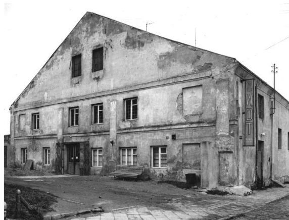
Ryc.13. Bet Midrasz w Kolnie, stan przed remontem
