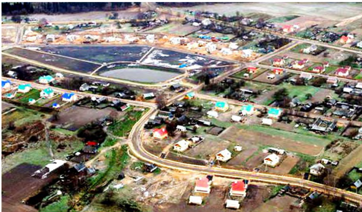
Рис. 3.14. Усадебная жилая застройка ведет к расползанию городов и, соответственно, транспортных и инженерных коммуникаций
