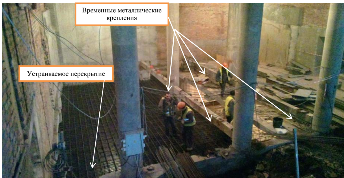
Рис. 2. Замена конструкций перекрытия после установки временных опор усиления
