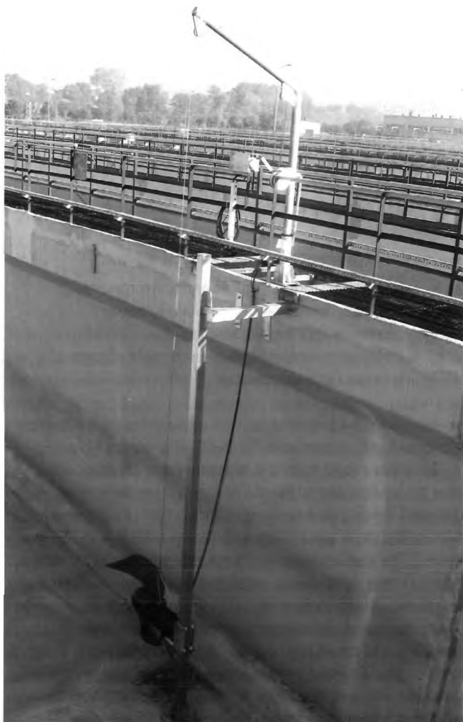
Рис. 8. Погружная мешалка типа MAXIPROP, установленная в реконструируемой секции биологических емкостей
