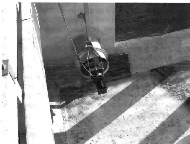
Рис. 9. Рециркуляционный насос WILoEMU RZP
