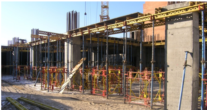
Рис. 6. Общий вид поддерживающих устройств с опалубкой ригелей до укладки плит
