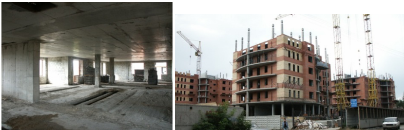
Рис. 7. Многоэтажный жилой дом в стадии строительства. Примеры. а) общий вид здания, б) интерьер, гладкие потолки позволяют устанавливать перегородки практически в любом месте перекрытия
