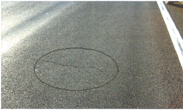
а) Нитевидные трещины
