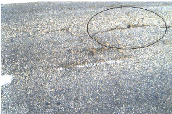
в) Трещины шириной раскрытия более 10 мм
