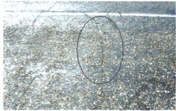
б) Трещины шириной раскрытия до 10 мм
