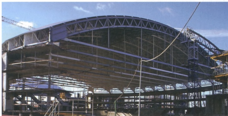
Рис. 1. Монтаж арок покрытия велодрома
