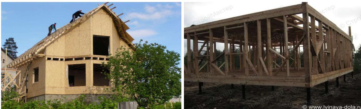
Рисунок 2 – Возведение каркасных домов
