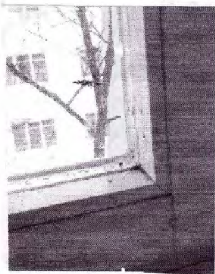
Рис. 5.24. Узел сопряжения наружной стены с оконным блоком: а – колония «грибка» на откосе; б – трехмерное температурное поле
