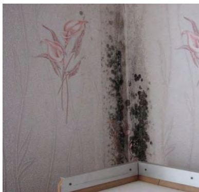
Рис. 1.6. Плесень и деформация обоев на внутренней поверхности наружных стен жилых комнат
