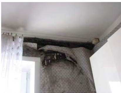
Рис. 1.6. Плесень и деформация обоев на внутренней поверхности наружных стен жилых комнат
