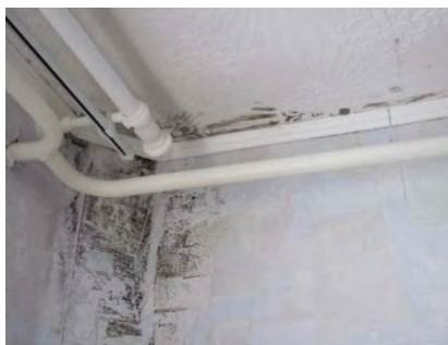
Рис. 1.6. Плесень и деформация обоев на внутренней поверхности наружных стен жилых комнат
