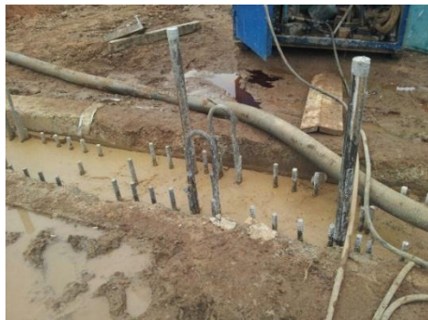
Рисунок 4. – Глинистый раствор между стенками форшахты
