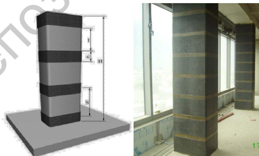
Рисунок 4 – Усиление колонны углеволоконными лентами
