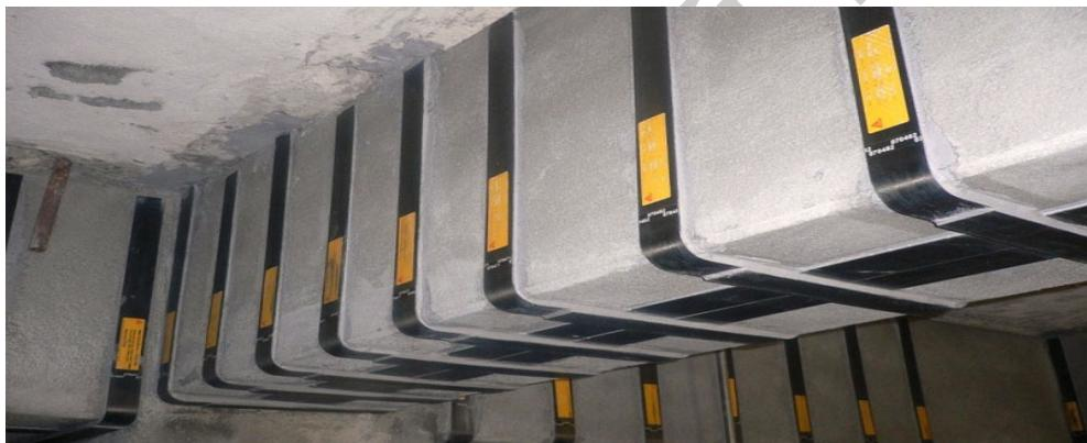
Рисунок 3 – Усиление железобетонной балки углеволоконным пластиком
