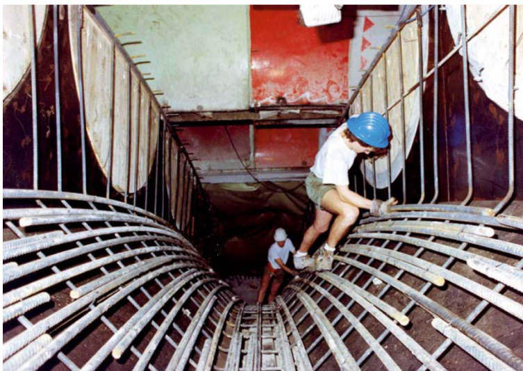
Рисунок 4 –Армирование поперечной арки с врезкой в продольные трубы на станции метро «Венеция». Милан, Италия [www.rocksoil.com]
