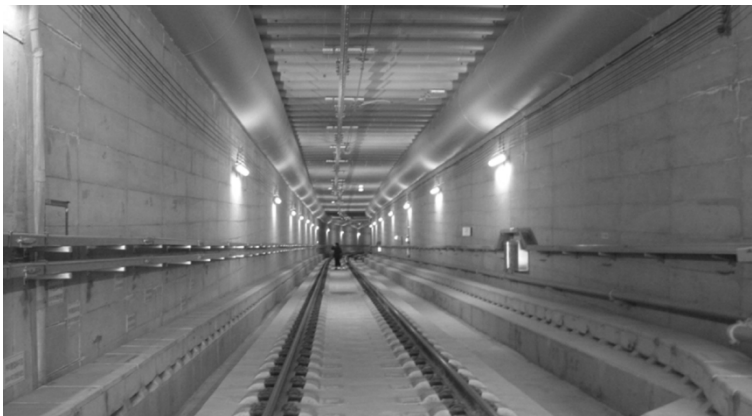
Рисунок 2 – Перегонный тоннель метрополитена Сеула с перекрытием поперечными армированными трубами, выполненное опережением забоя из угловых труб. Сеул, Республика Корея [4]
