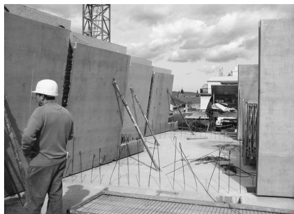
Рис. 5. Процесс строительства мансардного этажа жилого дома «CasaCascada» [7]
