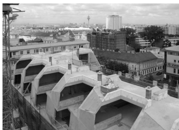
Рис. 3. Строительство мансардного этажа жилого дома «CasaCascada» [7]
