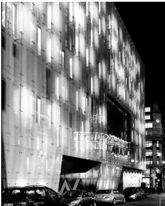
Рис. 1. На фасады отеля W London (архит. Джон Вайлс и Джеймс Диллей) нанесен специальный отражающий слой, на который проецируются цветные изображения видов Лондона с 8 камер, установленных на крыше здания
