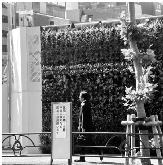
Рис. 3. «Живой» забор, ограждающий строительную площадку, Токио
