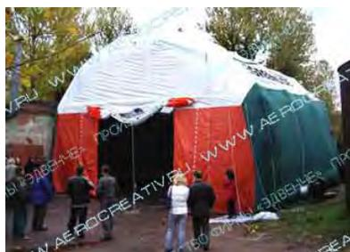
Рис. 5.14. Пневмокаркасная палатка
