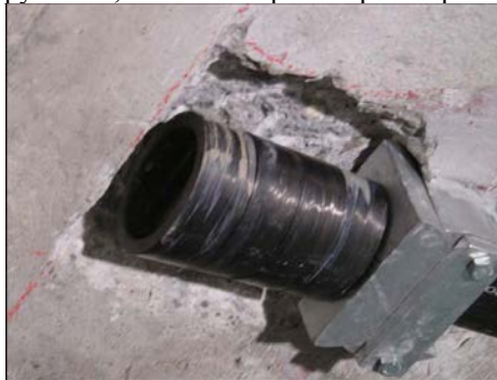
Рисунок 1. Анкеровка углеродной ленты
