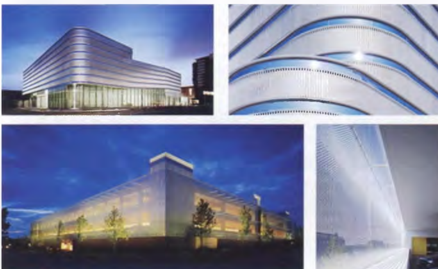
Рис. 10. Формирование стеновых ограждений с использованием гофрированных и перфорированных листов. Нидерланды, США
