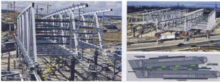
Рис. 6. Гараж-мост Neue Messe, конструктивное решение. Штутгарт, ФРГ
