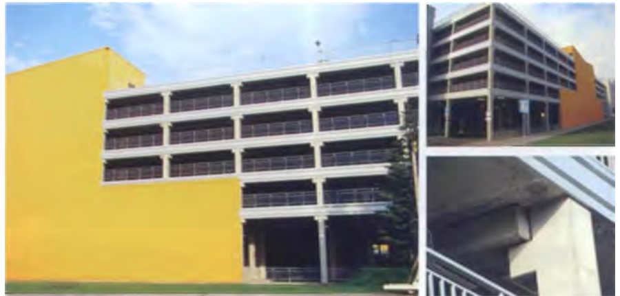
Рис 1. Первый многоэтажный гараж в Минске, возведенный с использованием сборного железобетонного каркаса концерна Consolis – крупнейшего производителя сборных бетонных конструкций в Европе (ЗАО «БЕТОНИКА», Каунас, Литва)
