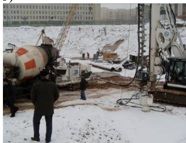
Рис. 6. Устройство буронабивной сваи при помощи полого непрерывного шнека
