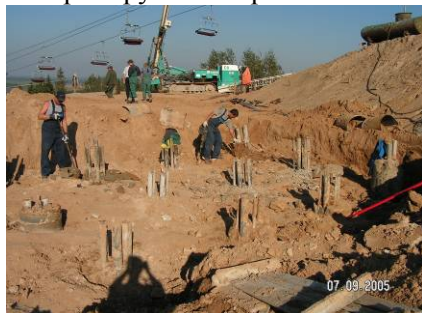
Рис. 10. Сваи для концевой опоры канатного подъемника трассы сноуборда в Силичах, выполненные по струйной технологии (на заднем плане виден станок фирмы «Kasagrande» для выполнения свай)
