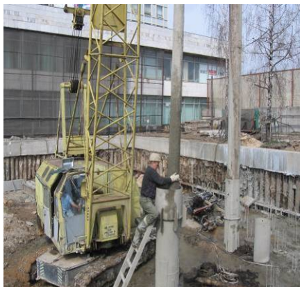
Рис. 4. Устройство буронабивных свай: слева – погружение желонки для выемки из обсадки слабых грунтов над уплотненной грунтовой пробкой, справа – вытеснение пробки второй трубой с глухим торцом
