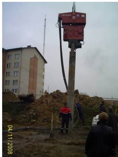
Рис. 5. Погружение труб подвесным безрезонансным вибропогружателем
