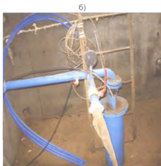
Рис. 5. Водозаборная скважина в дер. Узла Мядельского района Минской области а – конструкция скважины; б – общий вид оголовка с обвязкой
