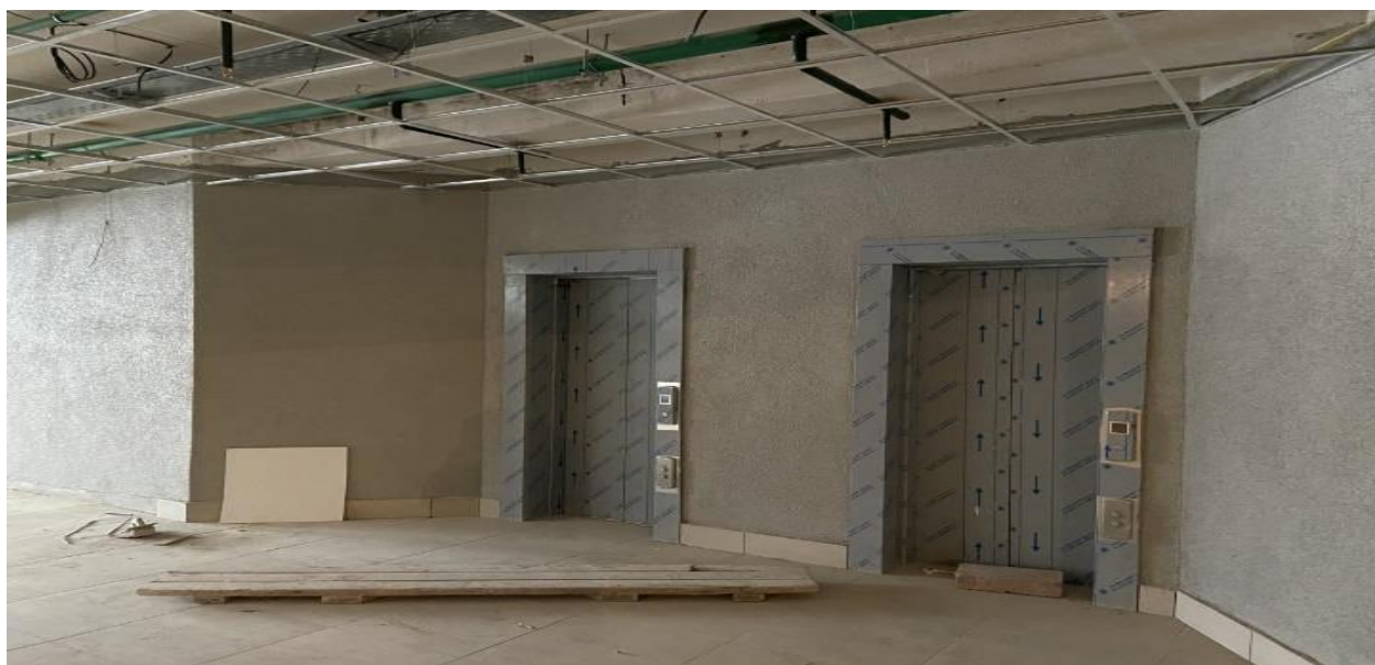
Реконструкция 15 корпуса БНТУ. Минск
