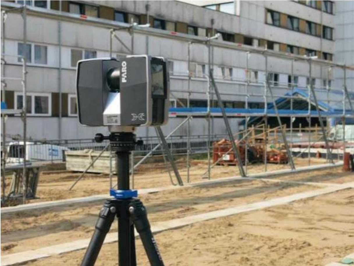
Рисунок 1 – Применение лазерного сканирования в строительстве
