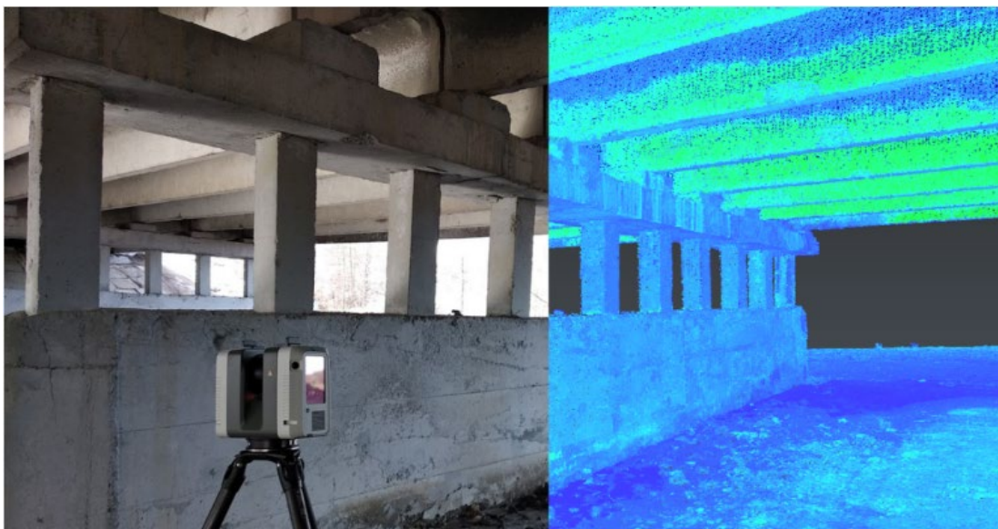
Рисунок 1 – Применение лазерного сканера для транспортных сооружений
