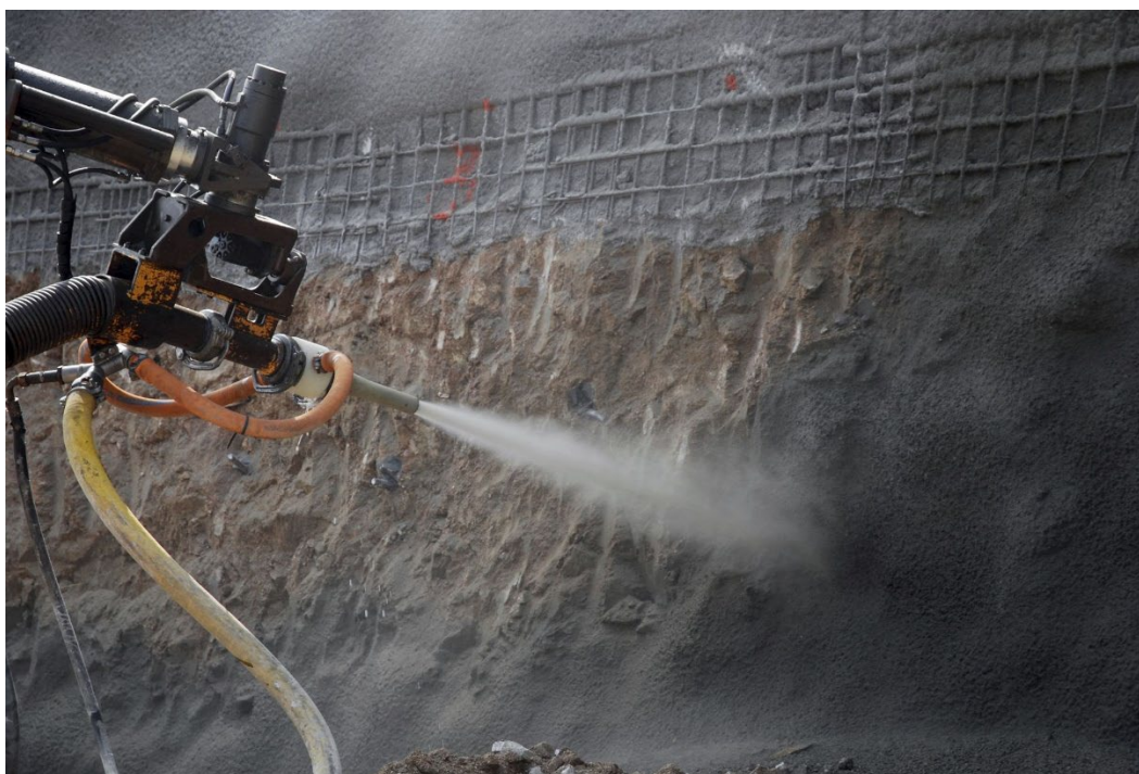
Рисунок 2 – Автоматизированное нанесение набрызгбетона (торкретирование) при устройстве удерживающих стен
