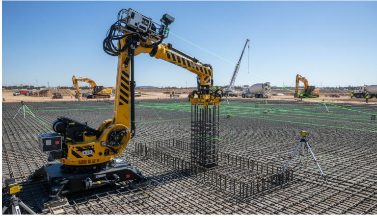
Рисунок 1 – Роботизированная система формирования арматурного каркаса при изготовлении плитного фундамента
