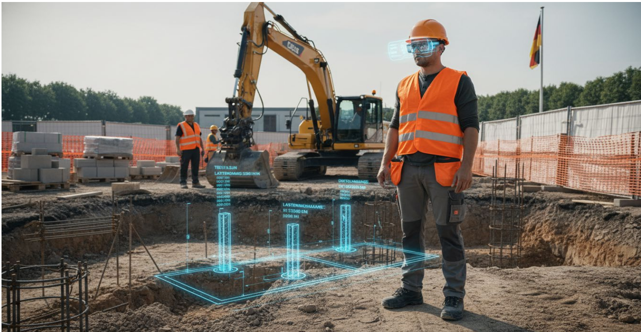
Рисунок 1 – Применение AR-технологии на стройплощадке фундамента (Германия)
