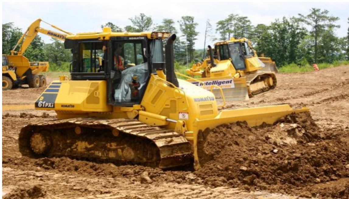
Рисунок 1 – Цифровизация строительной отрасли – работа команды Smart Construction
