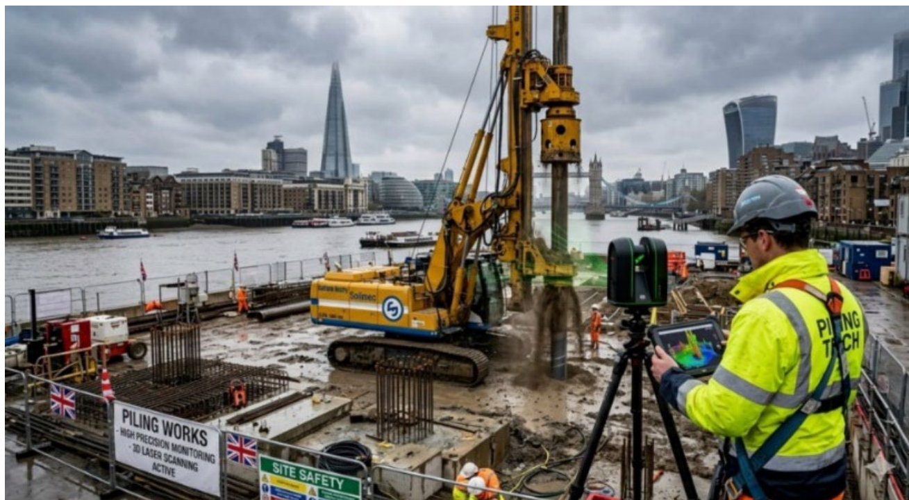
Рисунок 1 – Применение 3D-лазерного сканирования на строительной площадке во время изготовления свай в Лондоне
