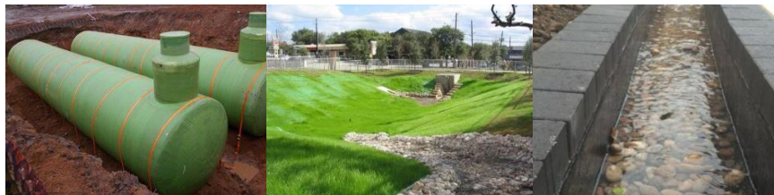
Рис. 2. Элементы «синей» инфраструктуры (подземные накопители, «сухой» пруд и водоотводный канал соответственно) [6]
