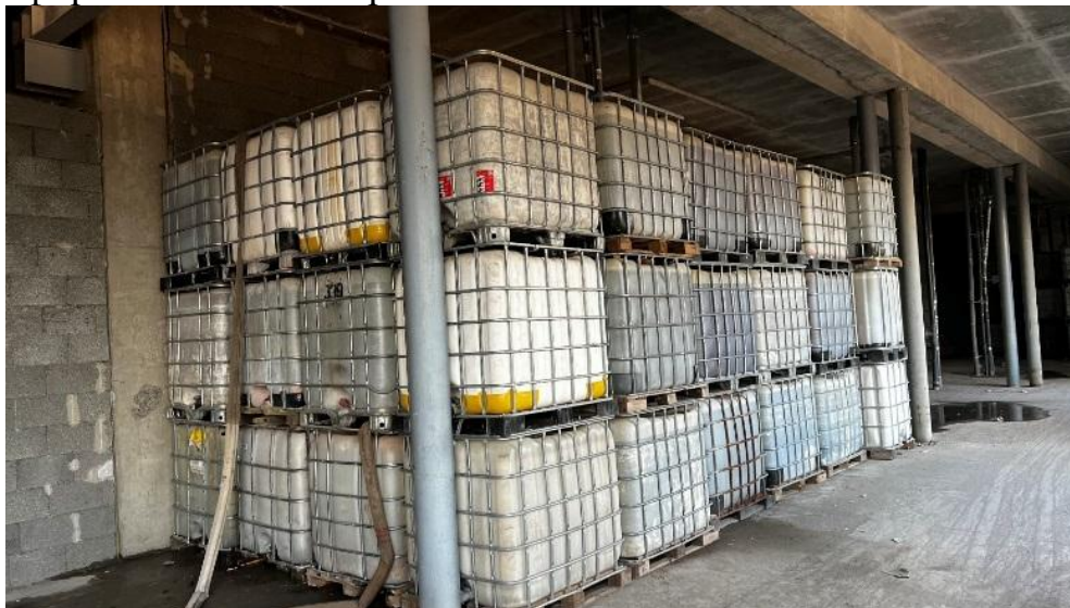
Рис. 1. Общий вид нагруженного фрагмента перекрытия
