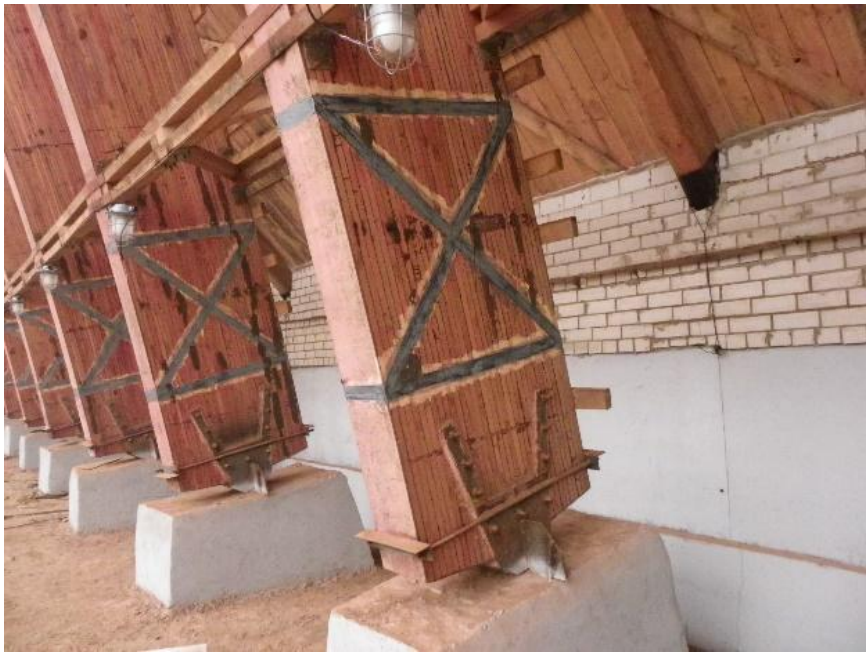
Рис. 6. Усиление приопорной зоны
