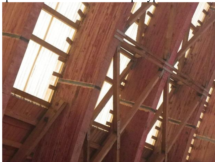
Рис. 5. Усиления арок углеродволоконными холстами без деревянных накладок
