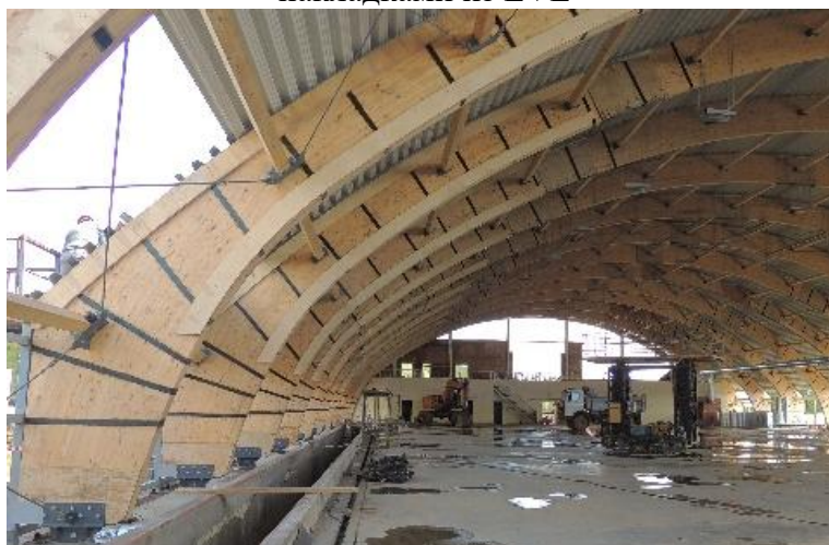
Рис. 8. Фрагмент усиления двухшарнирной арки
