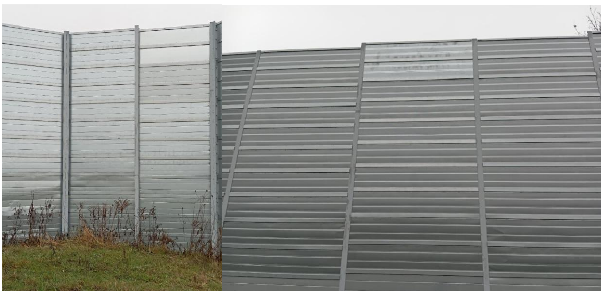
Рис. 4. Фрагменты усиления шумозащитного экрана с частичной заменой поврежденных панелей.
