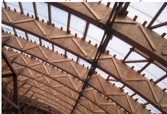
Рис.3. Общий вид арок склада, усиленного холстами и накладками
