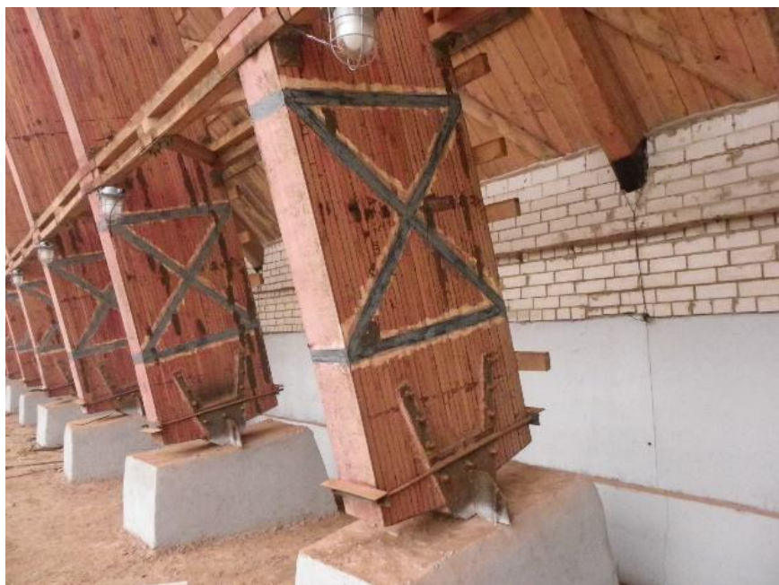
Рис. 6. Усиление приопорной зоны
